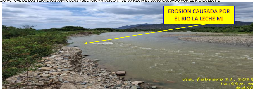
FIGURA N°03: SECTOR MAYASCON, EROSION CAUSADA POR EL RIO LA LECHE EN LA MARGEN IZQUIERDA AGUAS ABAJO, SE PROYECTA DEFENSA RIBERENA
